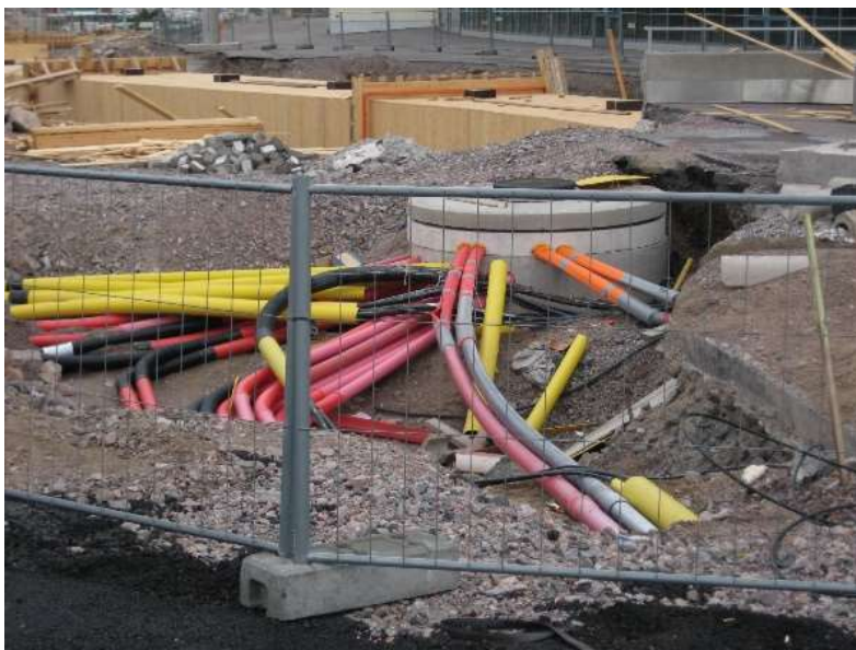
Kuva 15. Kuvassa DNA:n kaapelinsuojaputkia Hartwall-areenan työmaalta. Kuvan on ottanut Kari Värtinen.
