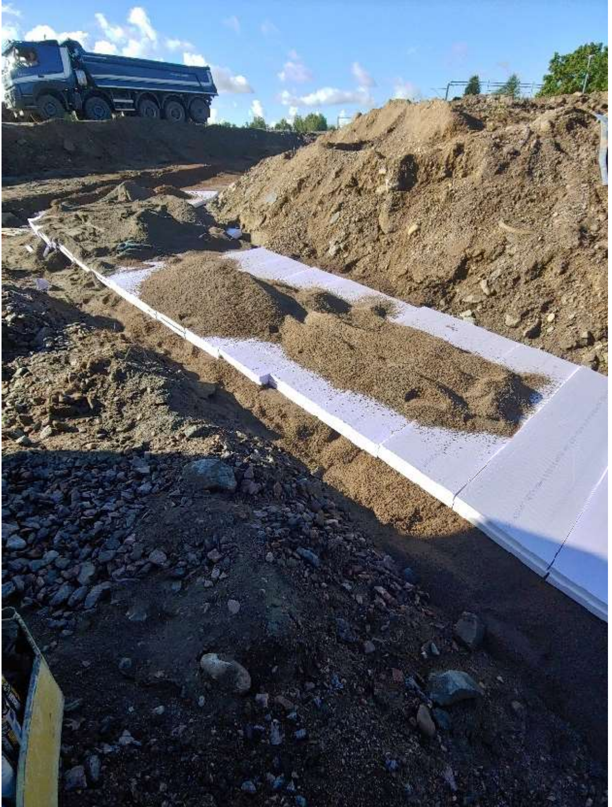
Kuva 11. Hulevesi pumppaamon linjojen routaeristys XPS-eristeellä Suurmetsäntien laidassa vuonna 2020. Kuvan on ottanut Bo Telén.
