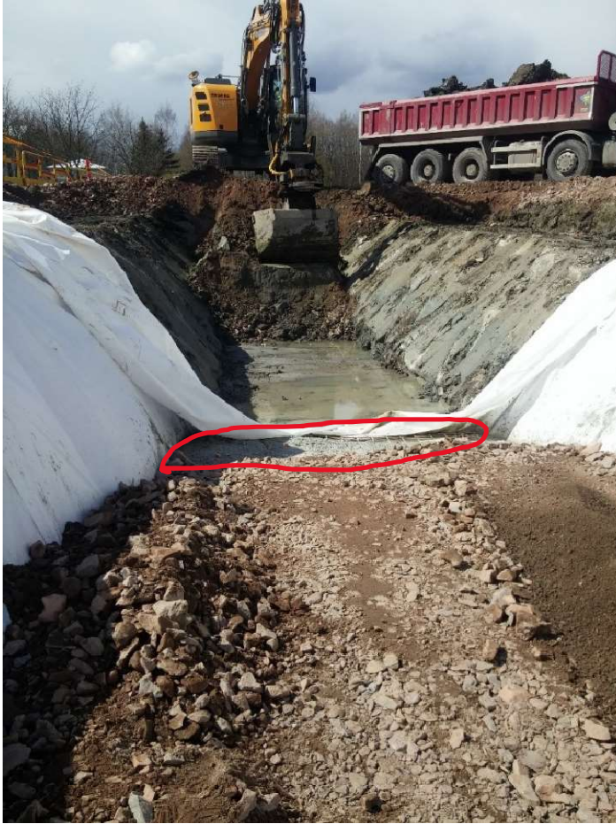
Kuva 8. Suodatinkangas erottamassa uuden kadun teräsbetonilaattaa ja murskekerroksia savisesta pohjamaasta. Pertunkuja vuonna 2017. Kuvan ottanut Bo Telén.
