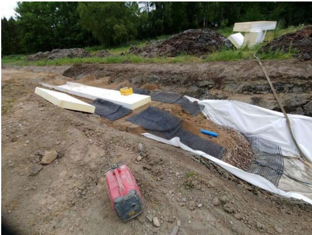
Kuva 7. Geolujiteverkkoa Fallkullan kotieläintilan lähistöllä vuonna 2019. Kuvan on ottanut Bo Telén.
